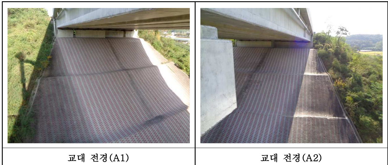
【사진 24.3.33】 교대 전경
