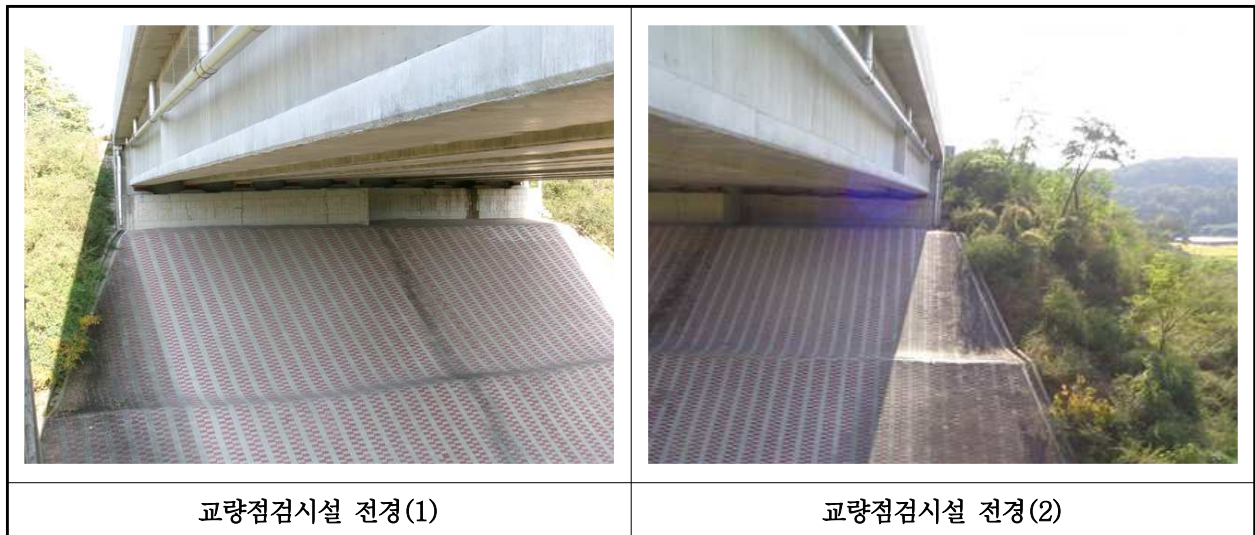
【사진 24.3.50】 교량 점검시설 전경
