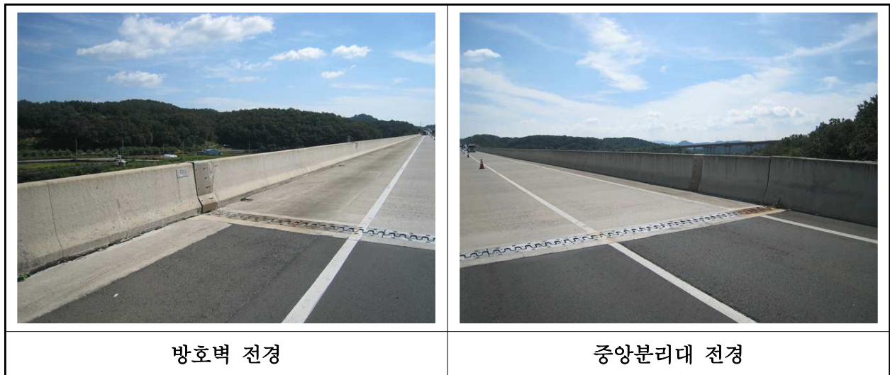
【사진 24.3.23】 방호벽 및 중앙분리대 전경
