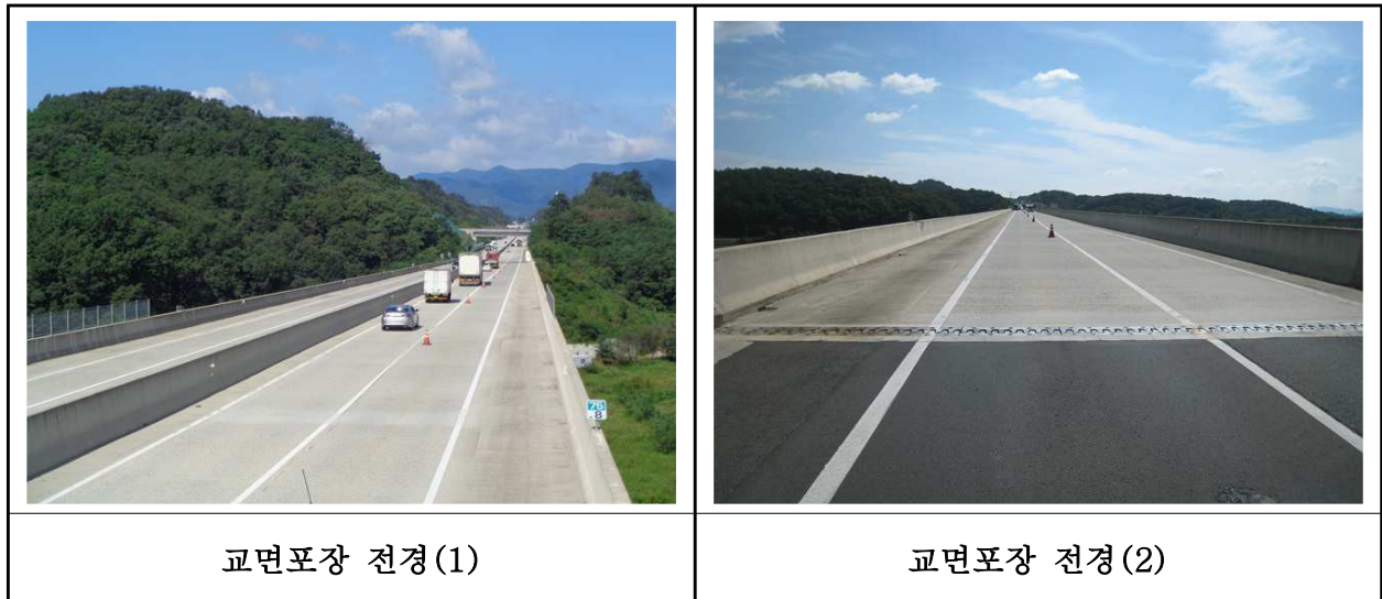
【사진 24.3.19】 교면포장 전경
