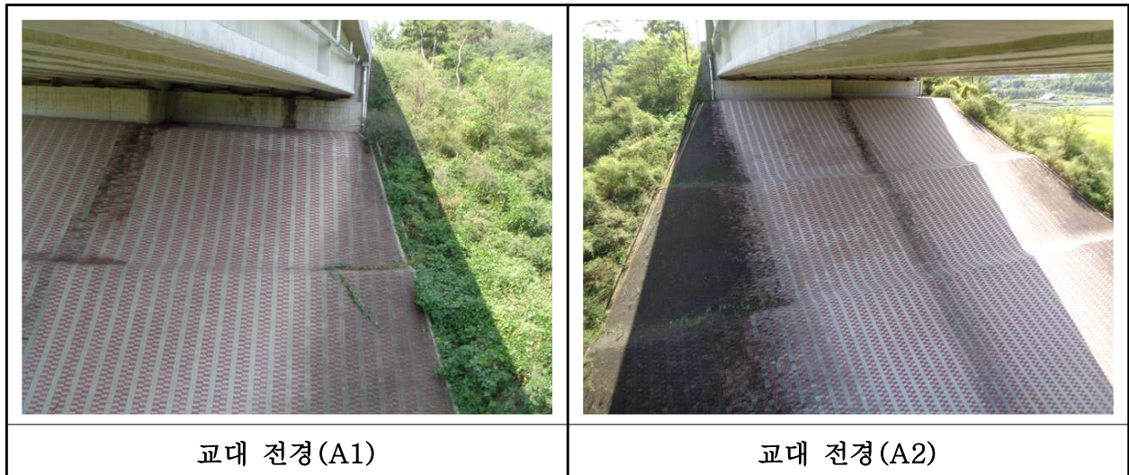
【사진 24.3.8】 교대 전경
