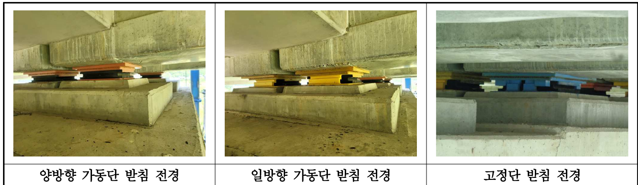
【사진 24.3.12】 교량받침 전경
