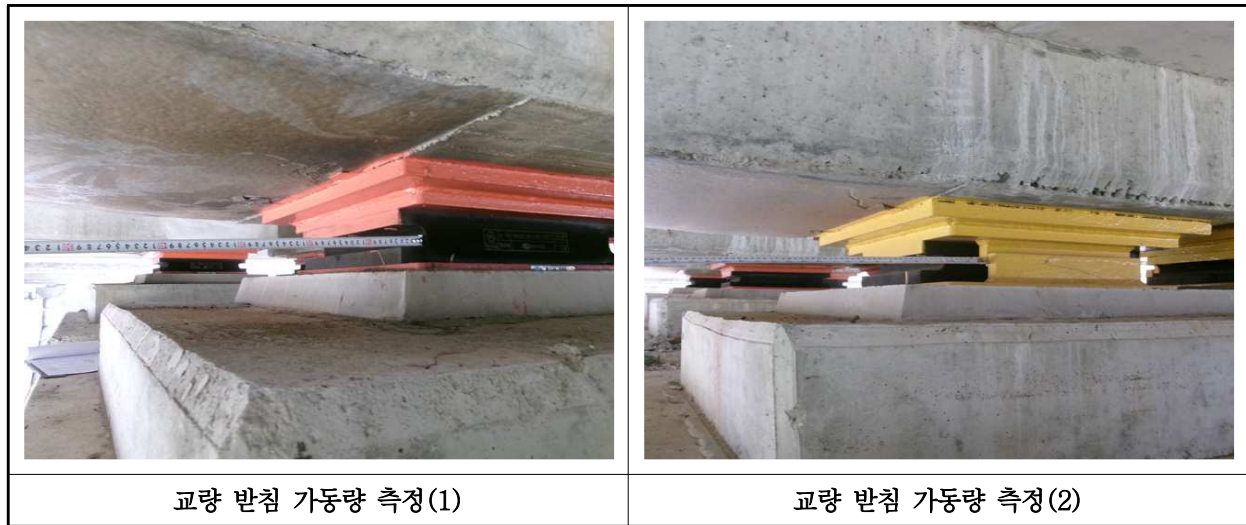
【사진 24.3.40】 교량받침 이동량 측정
