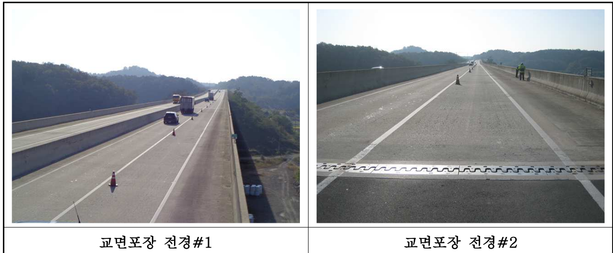
【사진 24.3.44】 교면포장 전경
