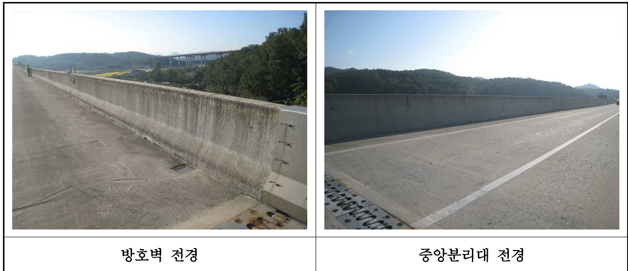
【사진 24.3.48】 방호벽 및 중앙분리대 전경
