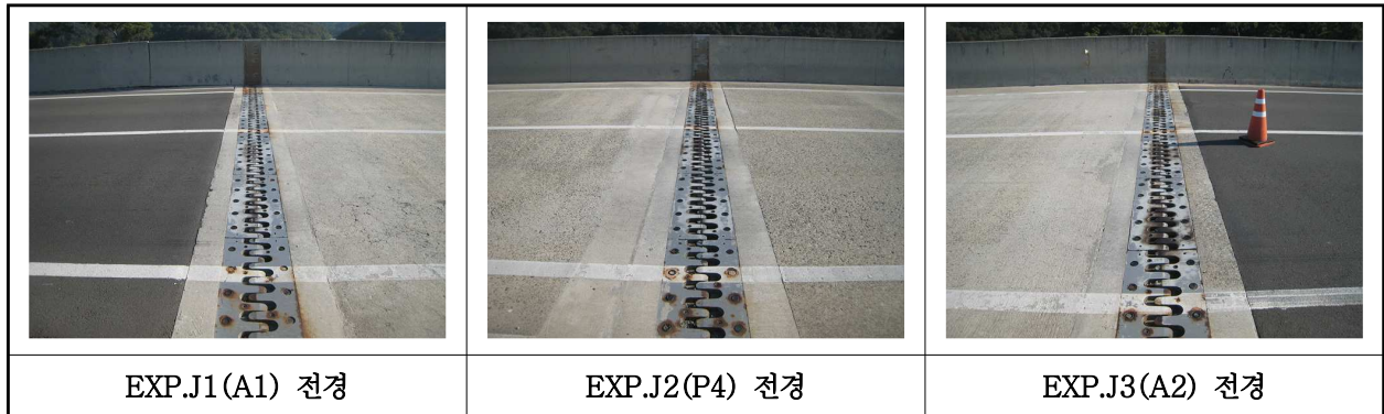
【사진 24.3.41】 신축이음장치 전경
