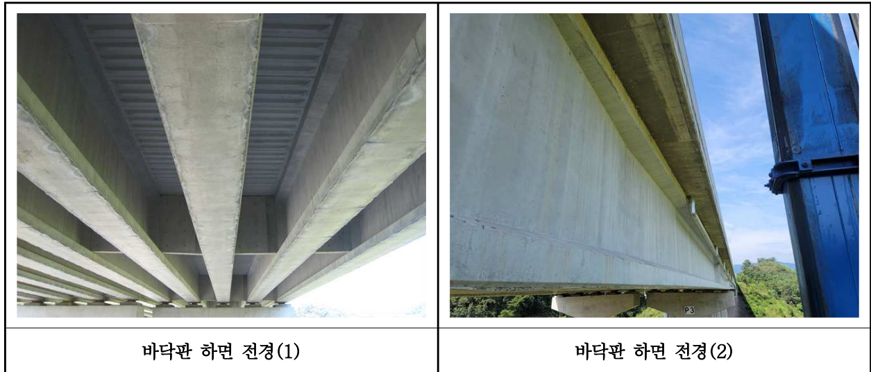
【사진 24.3.2】 바닥판하면 전경
