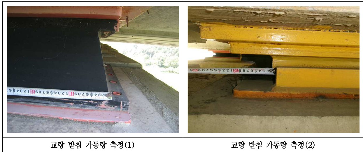
【사진 24.3.15】 교량받침 이동량 측정
