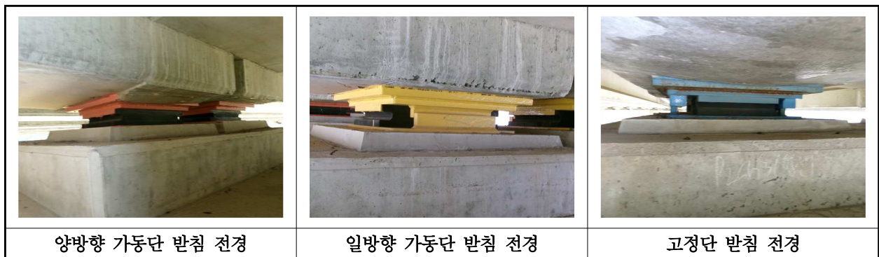
【사진 24.3.37】 교량반침 전경
