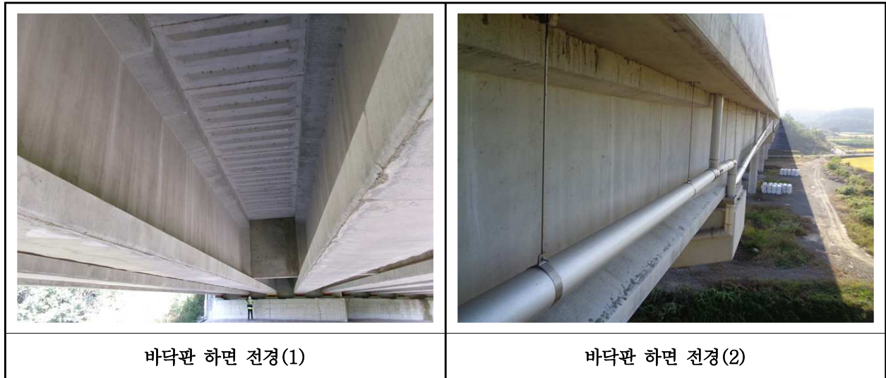
【사진 24.3.27】 바닥판하면 전경
