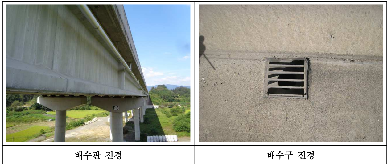
【사진 24.3.21】 배수시설 전경
