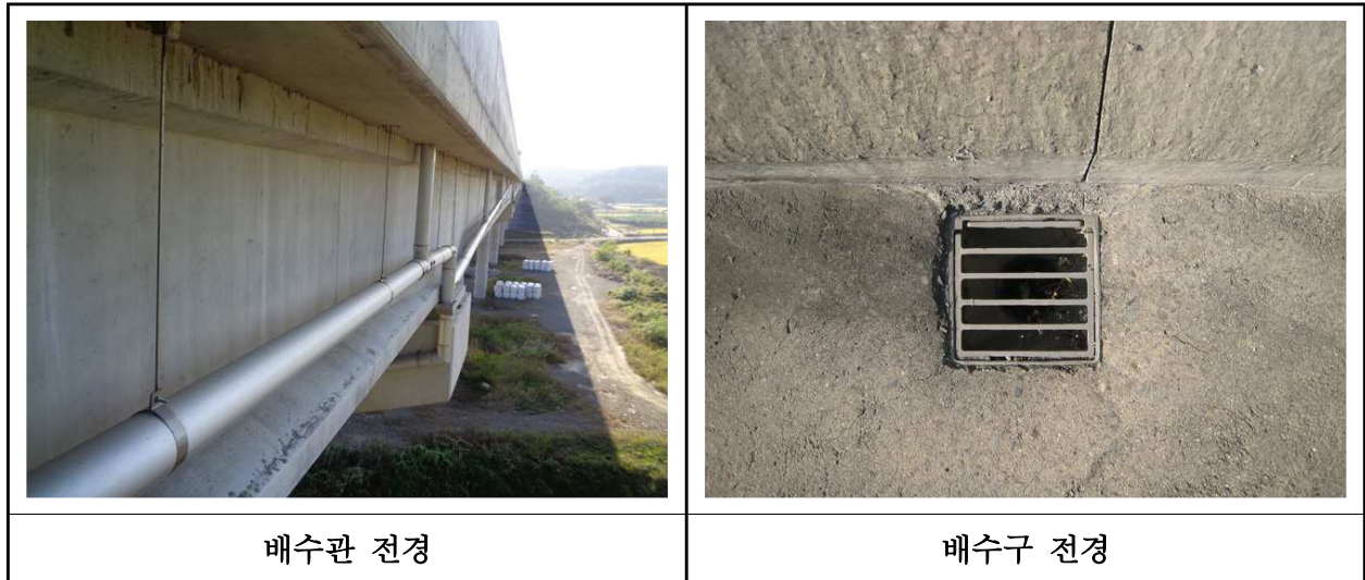
【사진 24.3.46】 배수시설 전경
