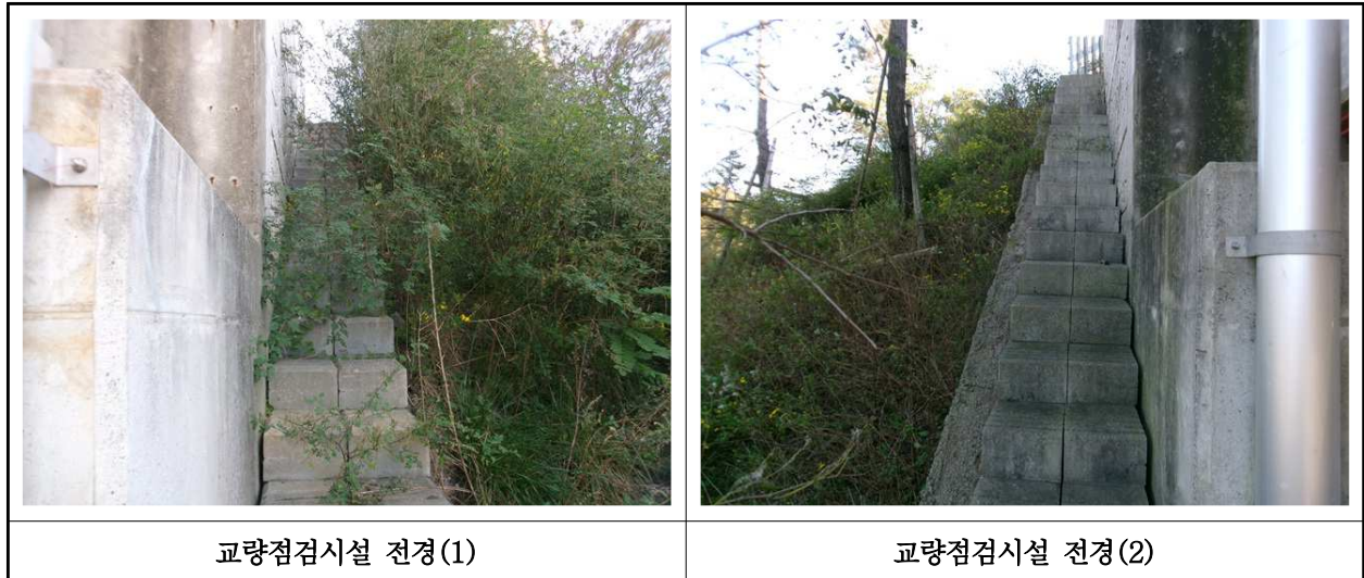
【사진 24.3.25】 교량 점검시설 전경
